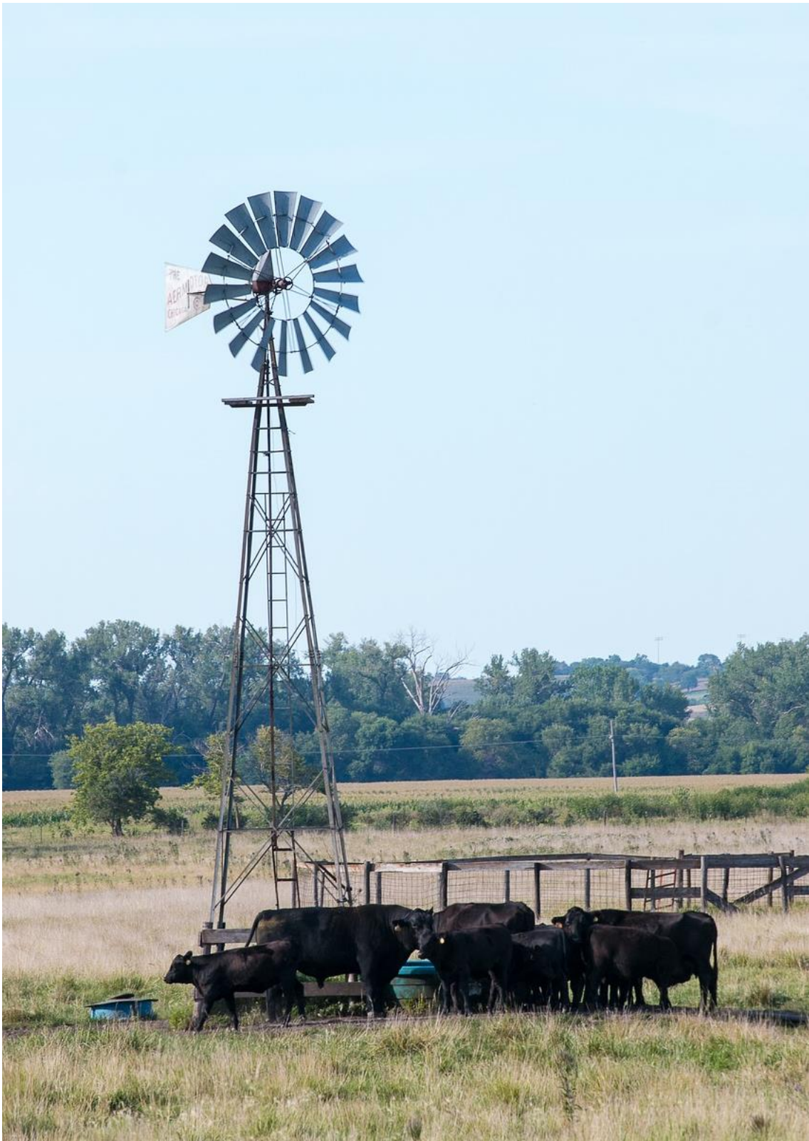
Figuur 8: Voorbeeld van een HAT met een grondopstelling met vakwerkmast
