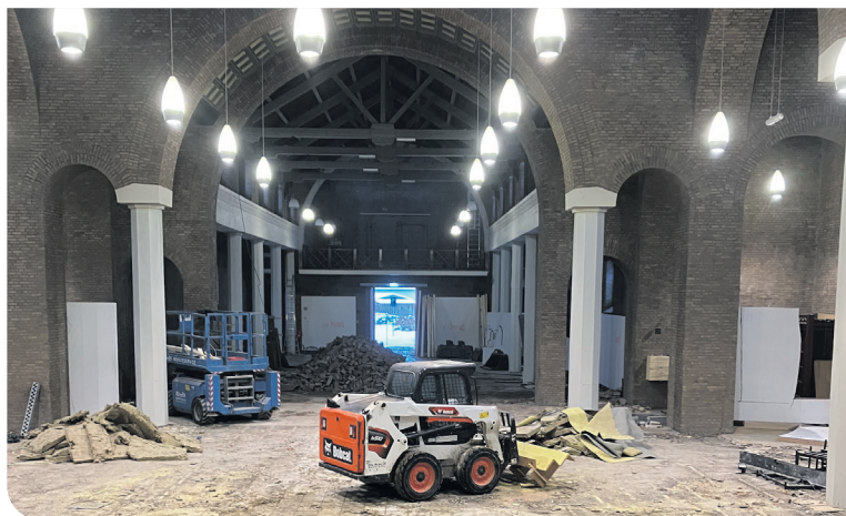
Werkzaamheden in de Martinuskerk in Doornenburg voor realisatie IKC De Doornick
