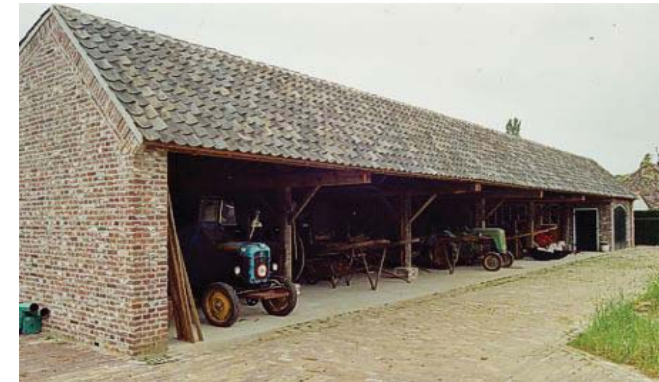
voorbeeld van functieverandering van een bedrijfsgebouw: ontwerp voor het omtoeveren van een Brabantse wagenschuur tot woning.
