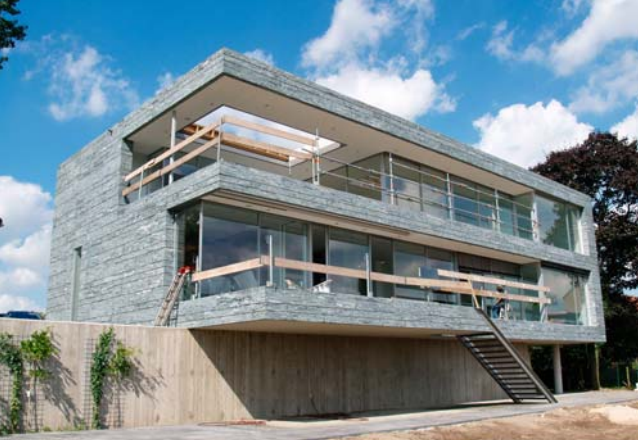
voorbeelden van dijkwoningen;
