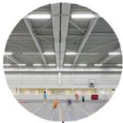
staalconstructie en dakplaat
