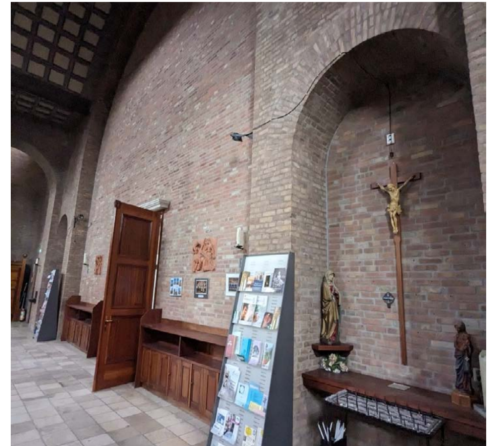
Dichtgezette wand tussen centraalbouw en schip
