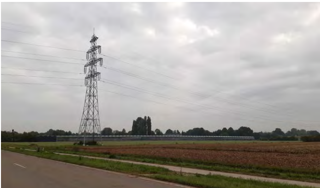
In het plangebied staat een hoogspanningsmast
