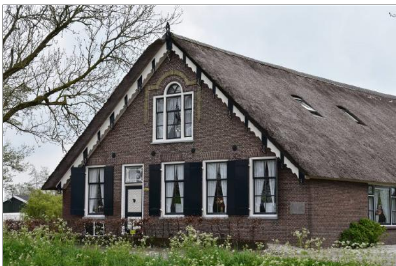
Boerderij Benedeneind Zuidzijde 269 in Benschop met serliana. Een serliana is een drielichtsvenster met een half rond bovenlicht.
