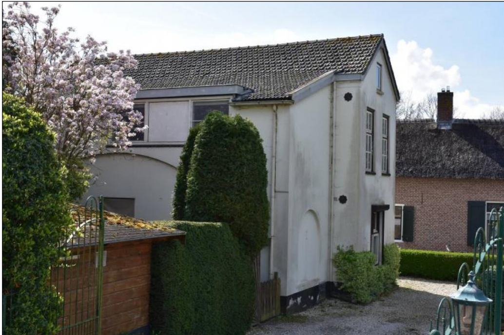
Het gemaal Wiel en Vogelenzang uit 1881. Door de dichtgezette kleine ronde boog in de achtergevel kwam het water naar binnen, de grote boog in de rechter zijgevel geeft de plaats aan van het waterrad.
