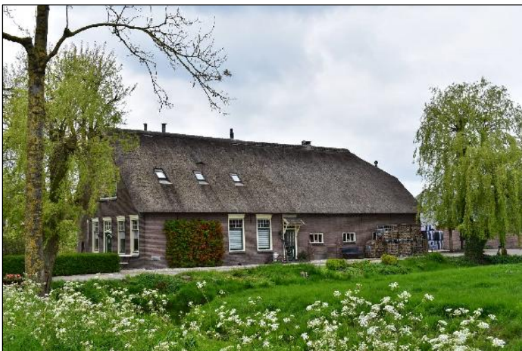
Langhuisboerderij Benedeneind Noordzijde 368 in Benschop. Woongedeelte en stal zijn hier duidelijk van elkaar te onderscheiden.
