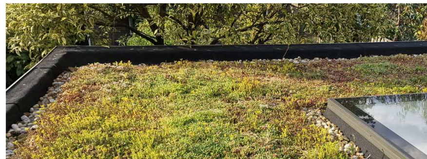
Groen dak met sedum
