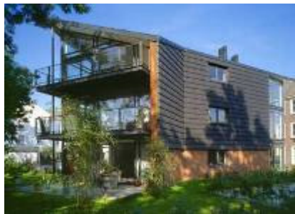
dakbedekking loopt door in gevel
