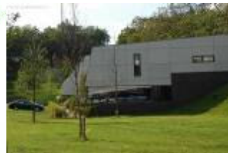
Parkeren onder de woning
