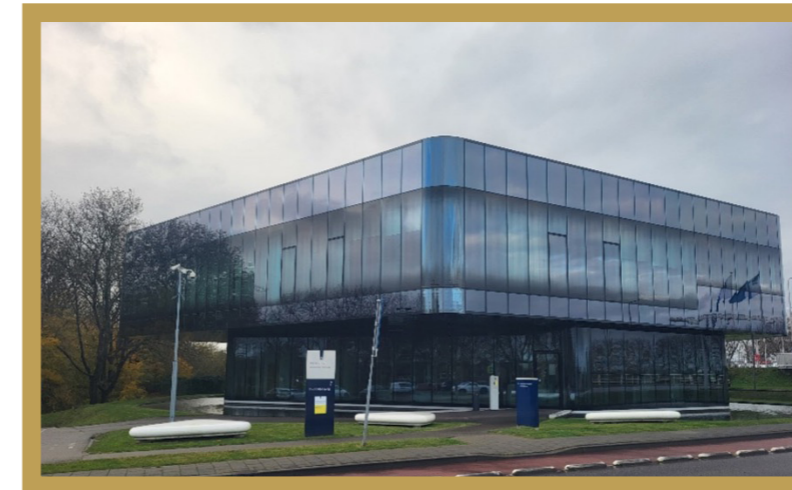
Figuur 2.4 Bediencentrale Rijkswaterstaat Bron: BCI & RHDHV, 2024
