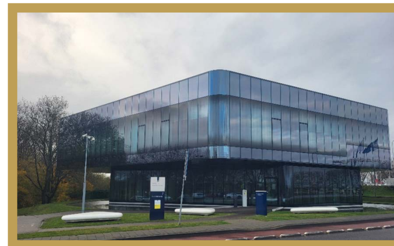
Figuur 2.4 Bediencentrale Rijkswaterstaat Bron: BCI & RHDHV, 2024
