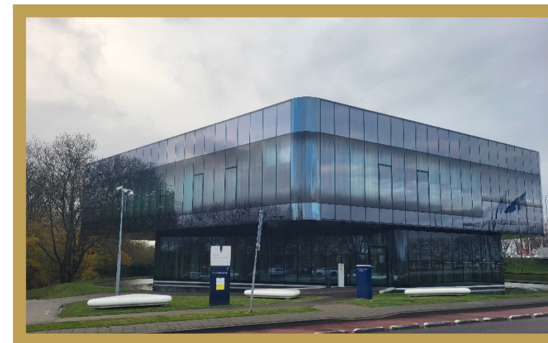
Figuur 2.4 Bediencentrale Rijkswaterstaat Bron: BCI & RHDHV, 2024
