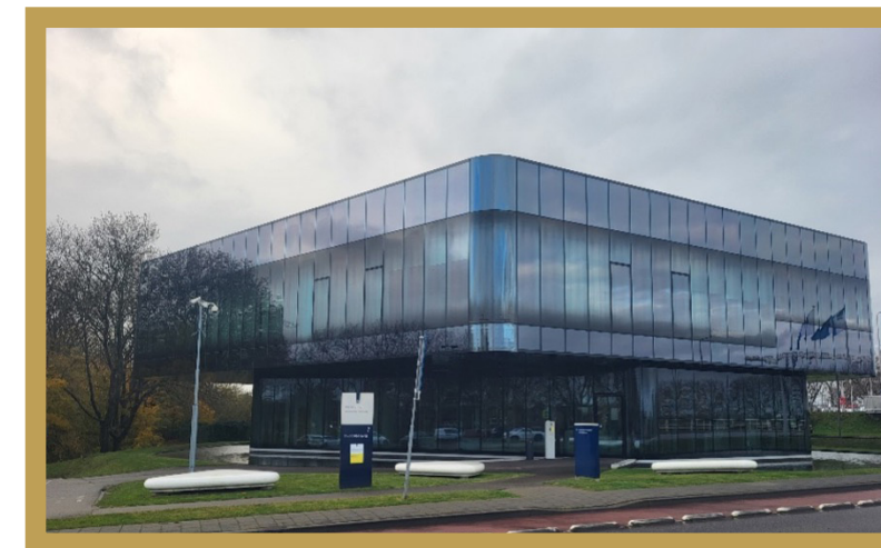
Figuur 2.4 Bediencentrale Rijkswaterstaat Bron: BCI & RHDHV, 2024
