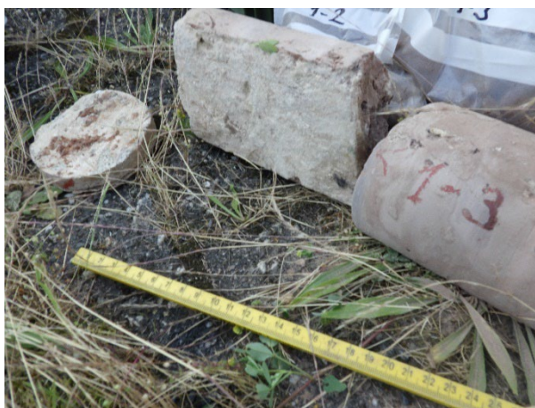
Figuur 3.5: Deel 1-2 in de lengte gebroken op de voeg
