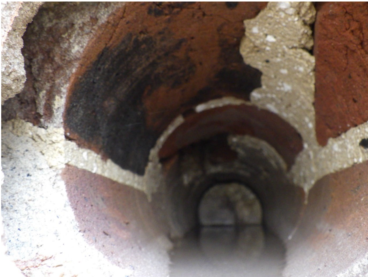
Figuur 3.26: Boorgat kern 4, van binnenuit gezien. Er staat iets water in
