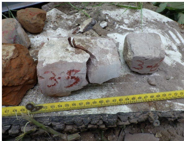
Figuur 3.24: Binnenzijde. Geen schade of verkleuring zichtbaar door de brand
