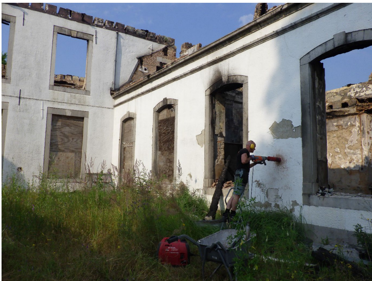
Figuur 2.1: Uitvoering boorwerkzaamheden bij locatie 1
