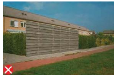
niet passend door afwijkende hoogte
