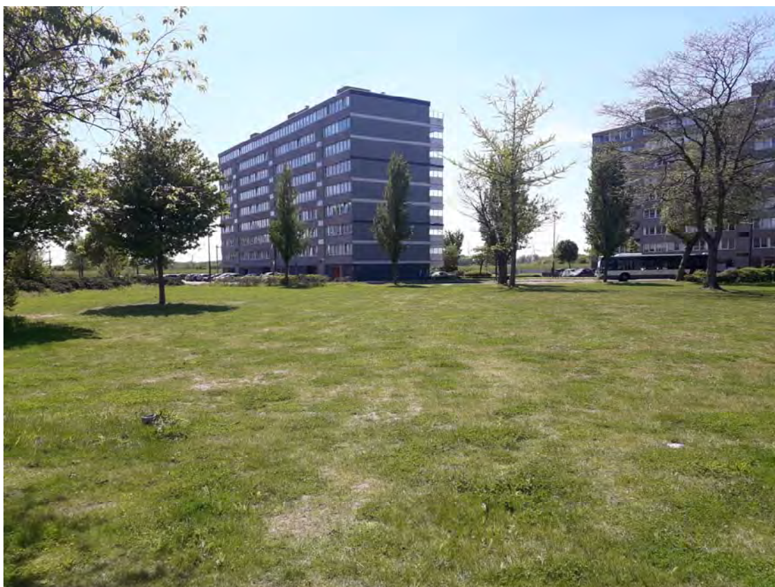
Foto 4, braakliggend terrein (zuidelijke richting)
