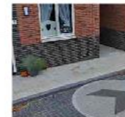
Trottoir nieuwe betontegels
