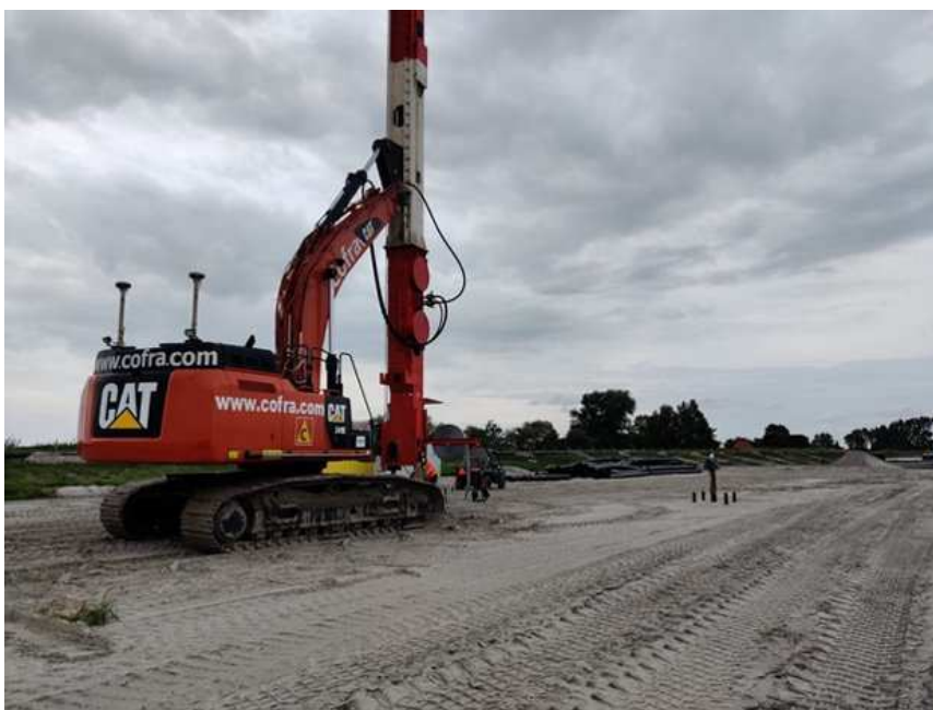
Afbeelding 3: Kraanopstelling voor aanbrengen verticale drainage
