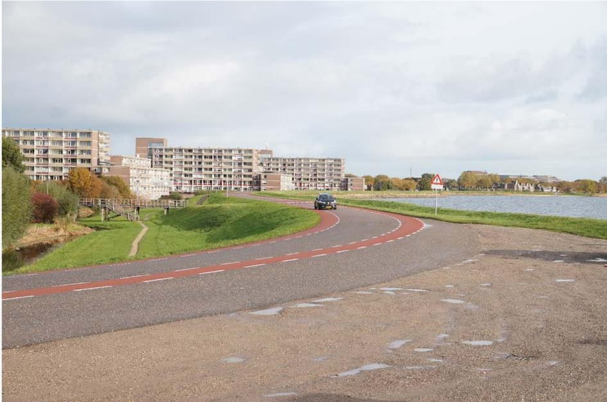
Afbeelding 9: Markermeerdijk vanaf de Galgenbocht naar het noorden
