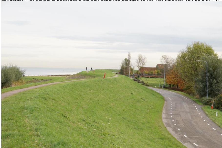
Afbeelding 51 Module 9: Markermeerdijk bij Broeckgouw
