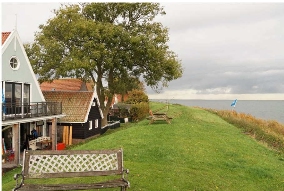
Afbeelding 20 Module 14: Uitdam dorp met bebouwing direct achter de dijk
