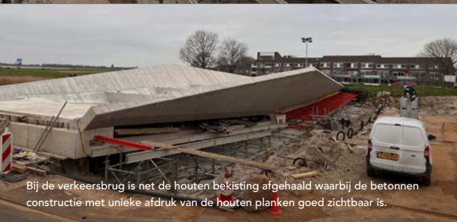
Dit is de fietsbrug bij het stadsstrand in Hoorn waarbij de bekisting wordt hergebruikt van de wandelbrug.
