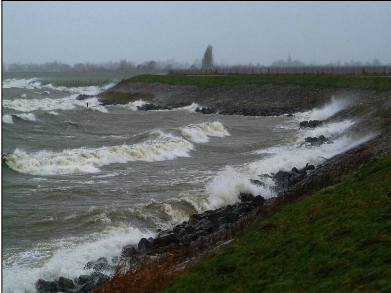
De bekleding van stenen en gras beschermt het dijklichaam tegen erosie door golfkrachten
