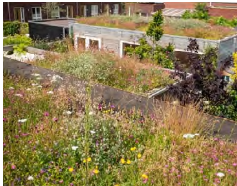
Groen-bruine daken bevordert goede afwatering (foto: De Dakvergroeners)
