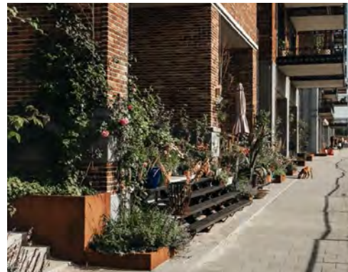
Verhoogd terras binnen de rooilijn zorgt voor een geleidelijk overgang naar de straat (Juurlink + Geluk, foto: via Landezine)
