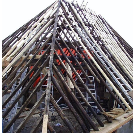
Sporenkap: alleen wat verrot was, is vernieuwd
