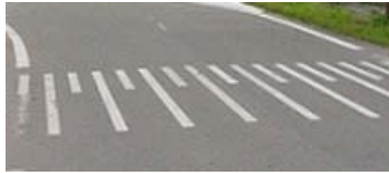
1. kruisingsvlak met belijning (suggestie van verhoging) snelheidsremmer ETW type 1 (CROW)
