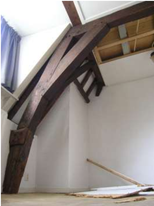
Verwijderen zachtboard plafonds
