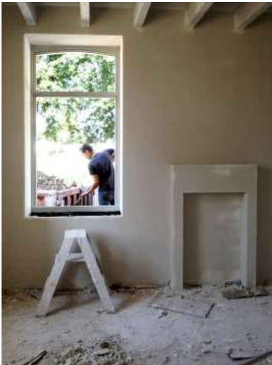
Vervangen pleisterwerk
