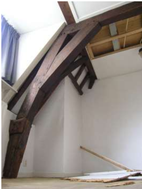
Verwijderen zachtboard plafonds
