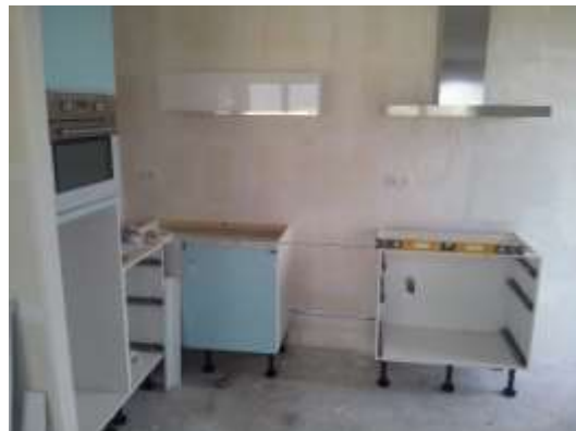
Plaatsen van nieuwe keuken
