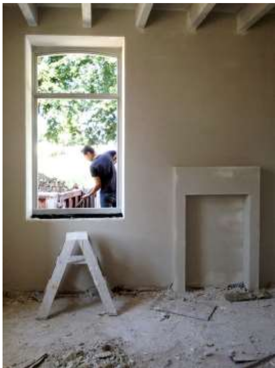
Vervangen pleisterwerk
