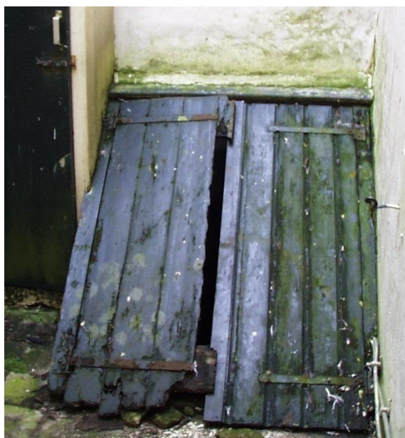
Voorbeeld van te vervangen kelderluiken
