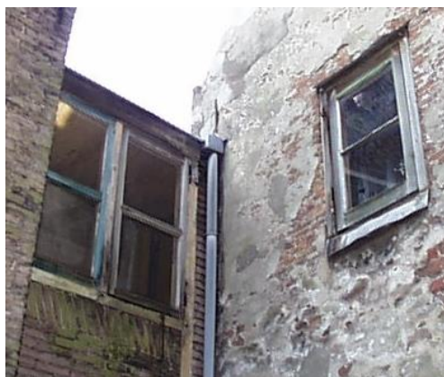
Voorbeelden van te vervangen (dak)ramen en kozijnen.
