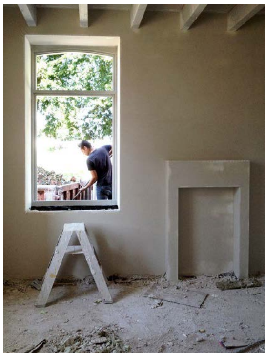
Vervangen pleisterwerk
