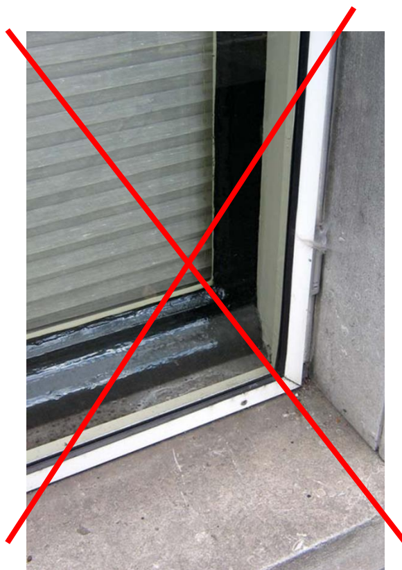
Voorzetraam (niet toegestaan)
