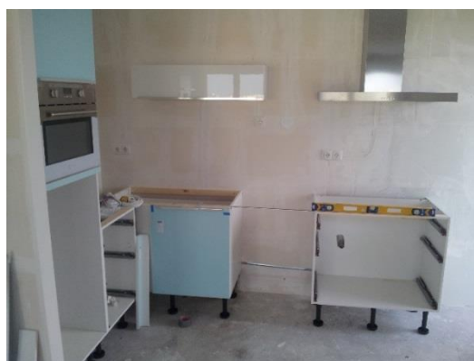
Plaatsen van nieuwe keuken
