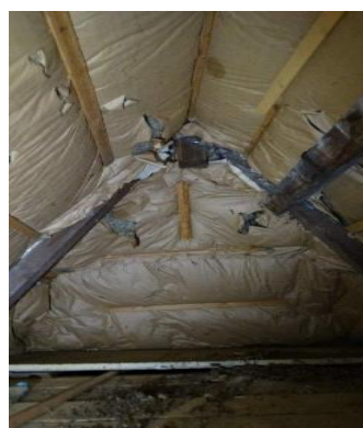
V.b. van verkeerd isoleren
