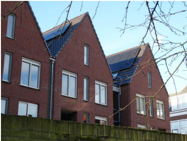
Zonnepanelen in dakvlak
