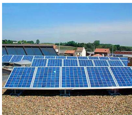
Panelen op plat dak
