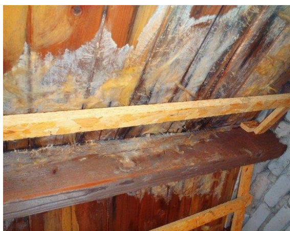
Voorbeelden van wat er mis kan gaan bij verkeerd isoleren
