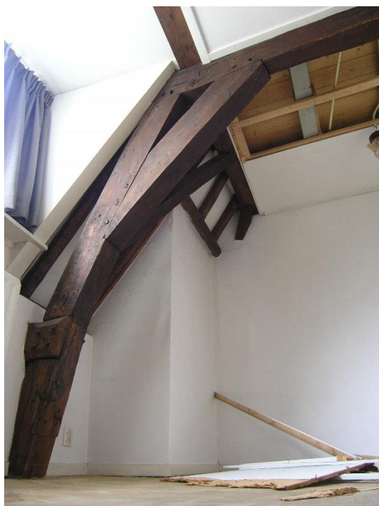
Verwijderen zachtboard plafonds
