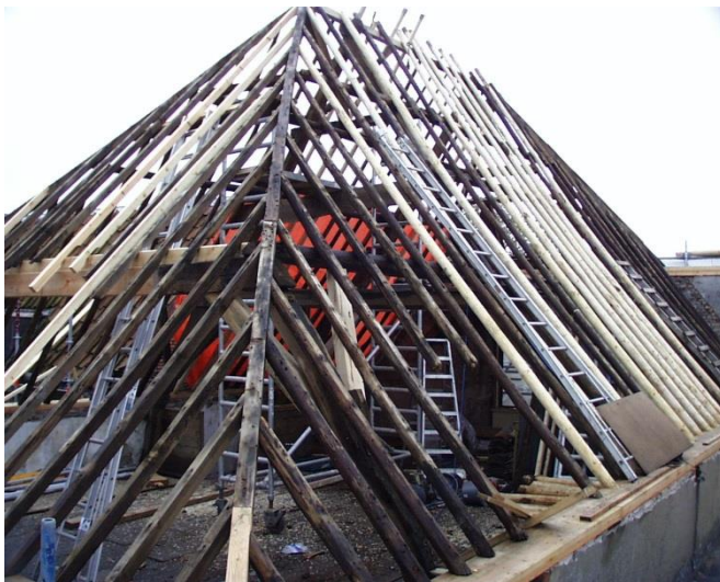
Sporenkap: alleen wat verrot was, is vernieuwd
