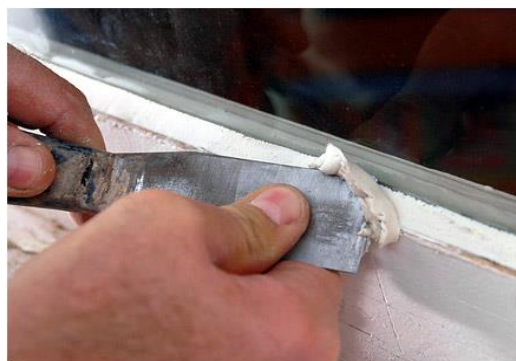
Nieuw glas geplaatst met stopverf
