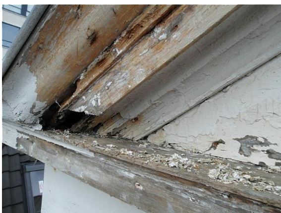
Verval door achterstallig onderhoud
