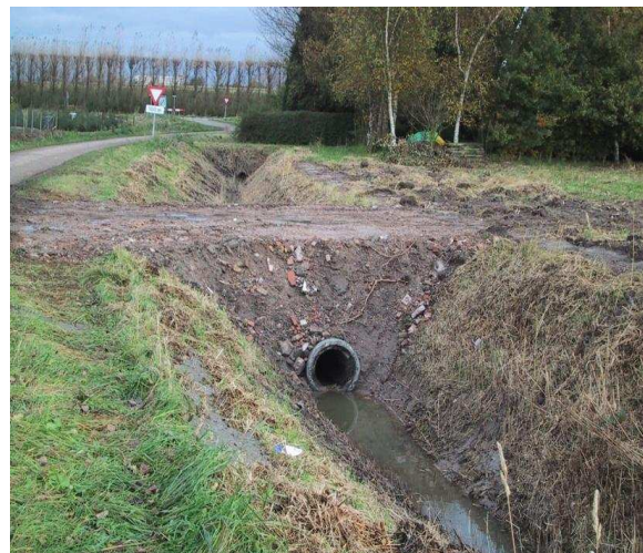
Figuur 4 Nieuwe dam welke samengesteld is uit oud dammenmateriaal.
