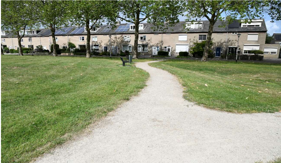
Foto: Prinsenhove: pad met halfverharding
