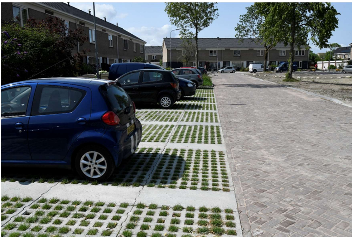
Foto: Radenhove: aanleg groene parkeerplaatsen, hergebruik materialen in rijbaan.
