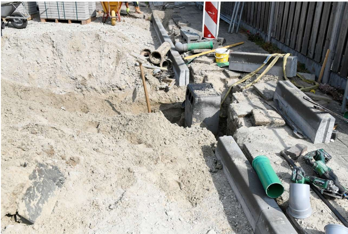
Foto: werkzaamheden aan de riolering en wegen in de Adriaen Obrystraat
