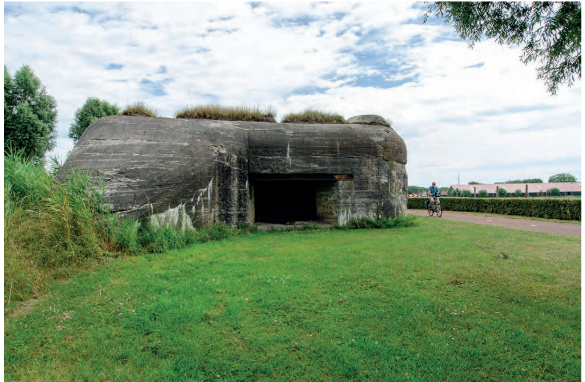
▼ Langs het Bunkerpad staan bunkers uit de Tweede Wereldoorlog
