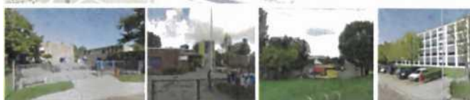
Maatschappelijke voorzieningen zijn aan verduurzaming toe
