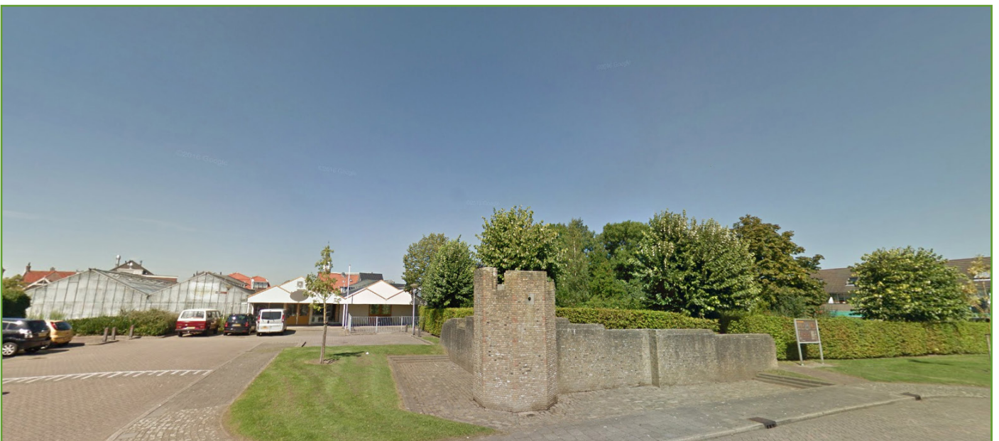
Huidige kassen en opgemetselde kasteelmuur
