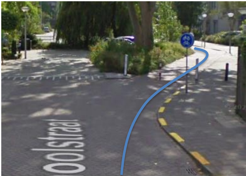
(4) Einde schoolstraat waar het fietspad begint.
