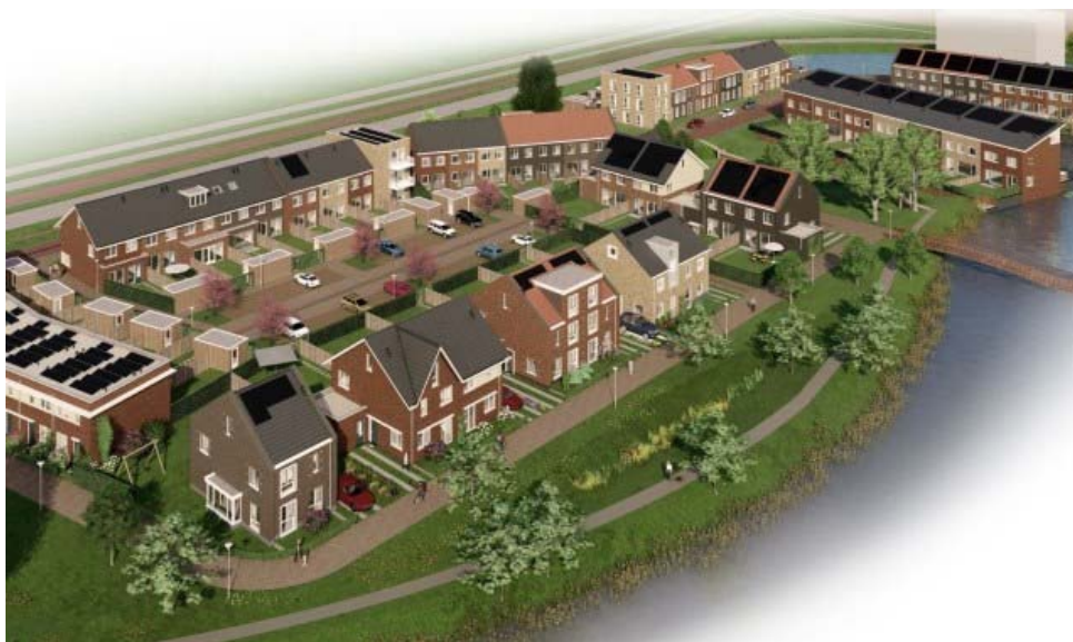
Figuur 24 – nieuwbouwlocatie de Kreek.
