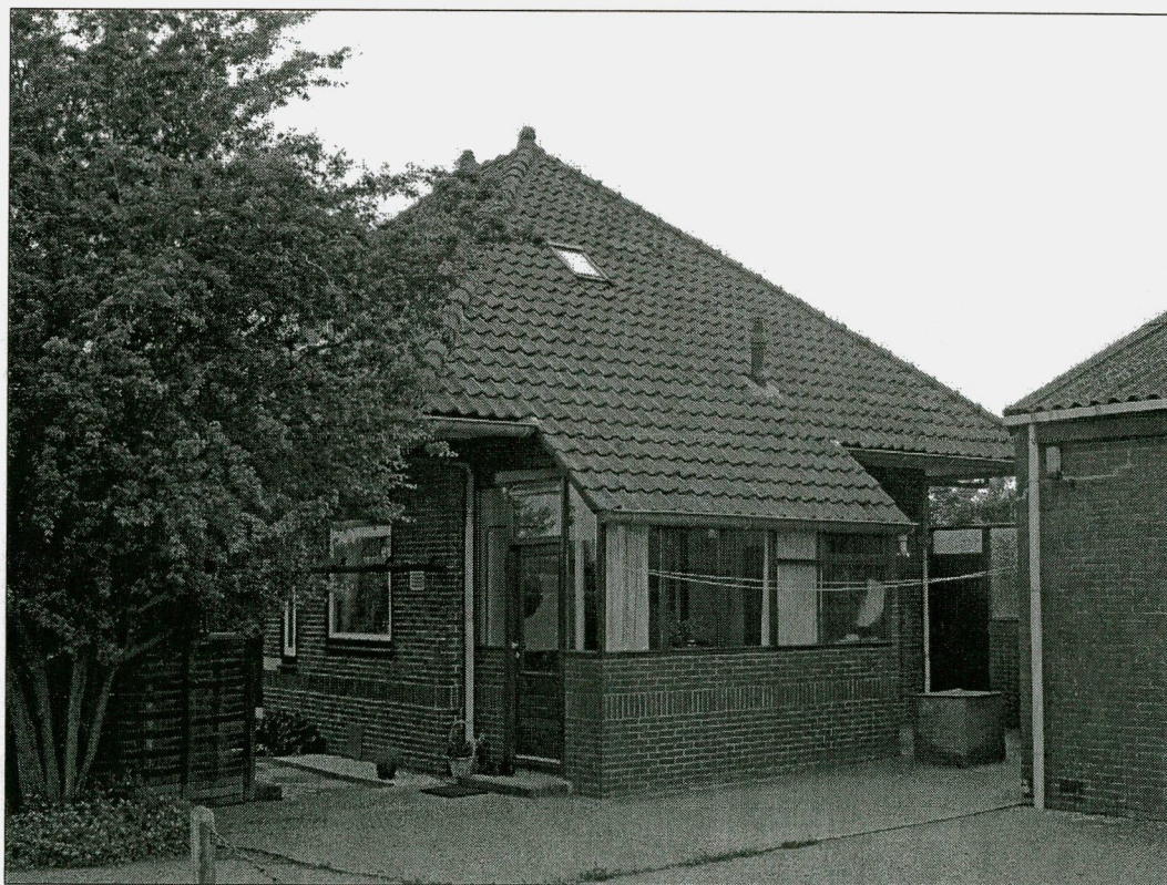
Achtergevel met aangebouwde keuken. Rechts de stenen schuur.
