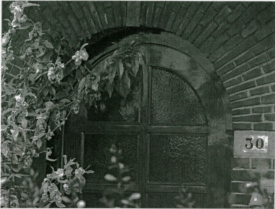
Voordeur uit de bouwtijd met brede boogvormige strek.
