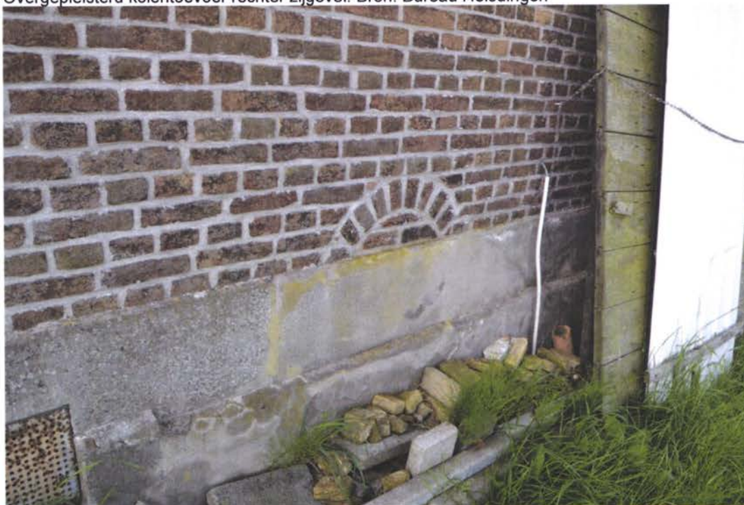
Overgepleisterd kolentoevoer rechter zijgevel. Bron: Bureau Helsdingen
