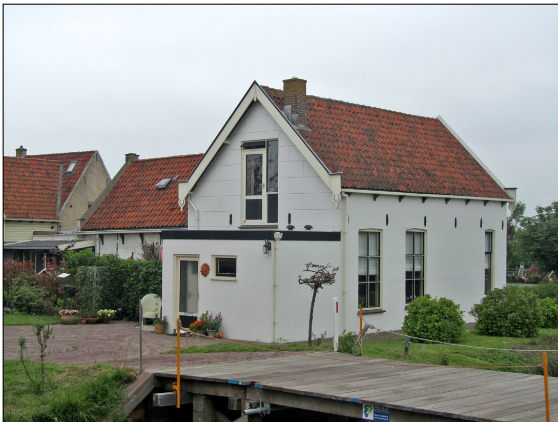
Kwakelweg 2 vanaf de Kwakelweg. Uitbouw met toegangsdeur.
