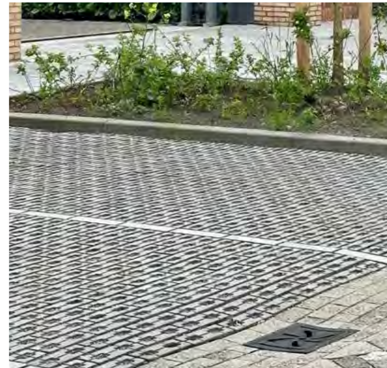
waterdoorlatende bestrating parkeerplaatsen
