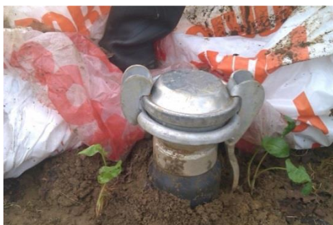
Figuur 4. Gesloten put voor agrarisch gebruik.
