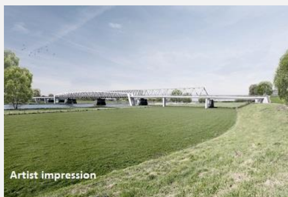
Fietsbrug over de Maas (MaasWaalpad)
