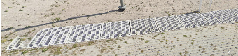
Figuur 4-13: Voorbeeld geluidsmuur in de grond. Deze wordt langs de weg aangebracht.
