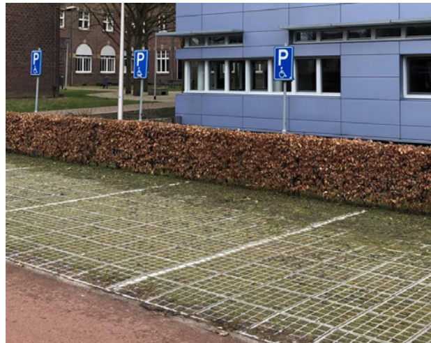
Parkeren op waterdoorlatende verharding
