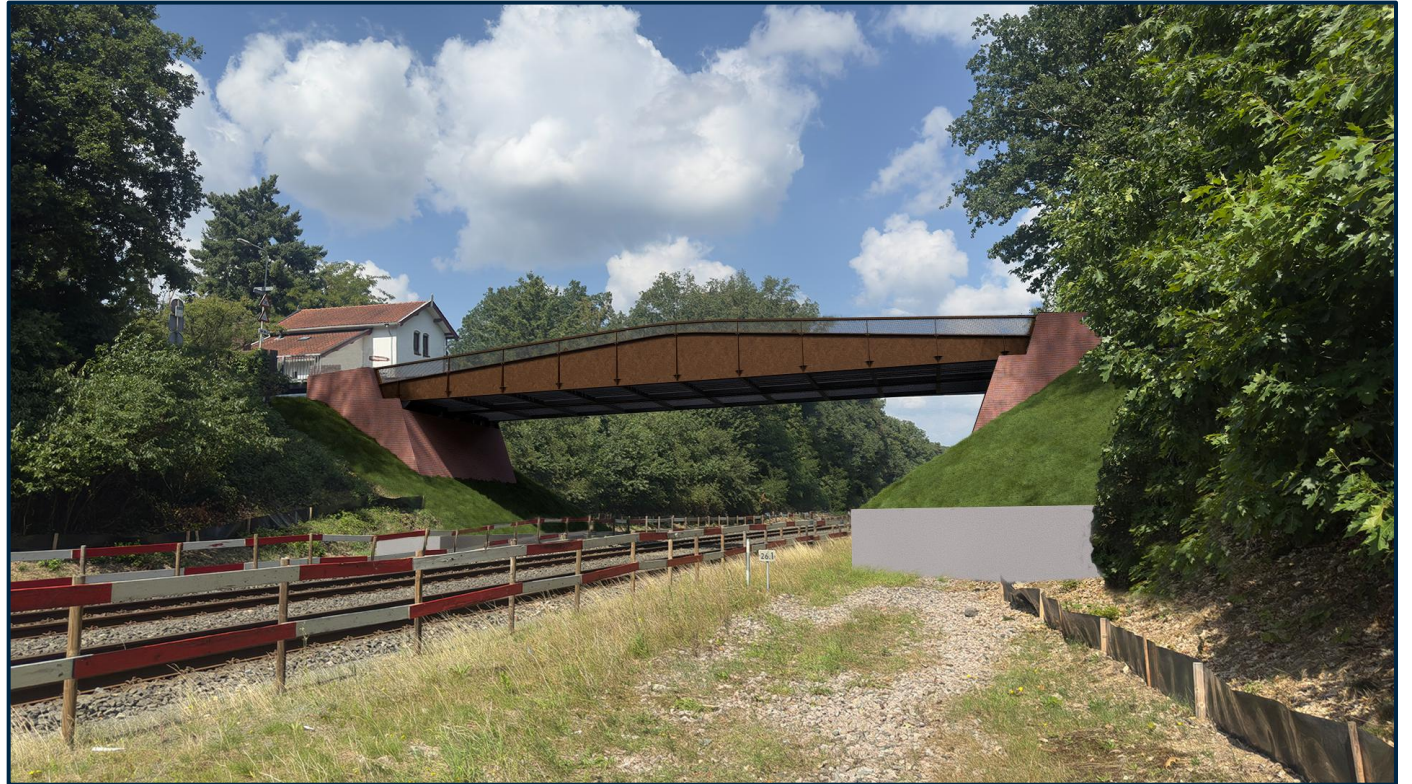
Nieuw viaduct Heumensebaan
