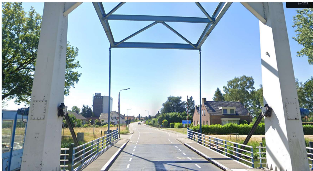
Afbeelding 20. Eind ter hoogte van Leveroysebrug (bron: Google Maps, juni 2023)
