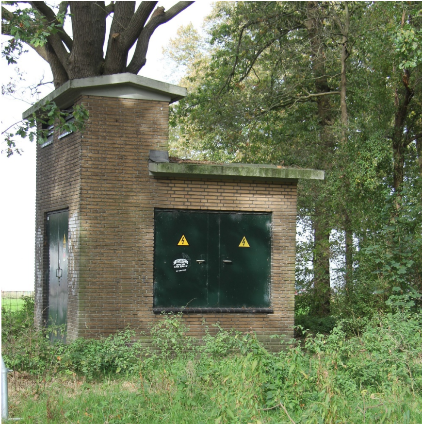
Afb. 27. Ook de trafo uit 1926 nabij sluis 15 is klein
