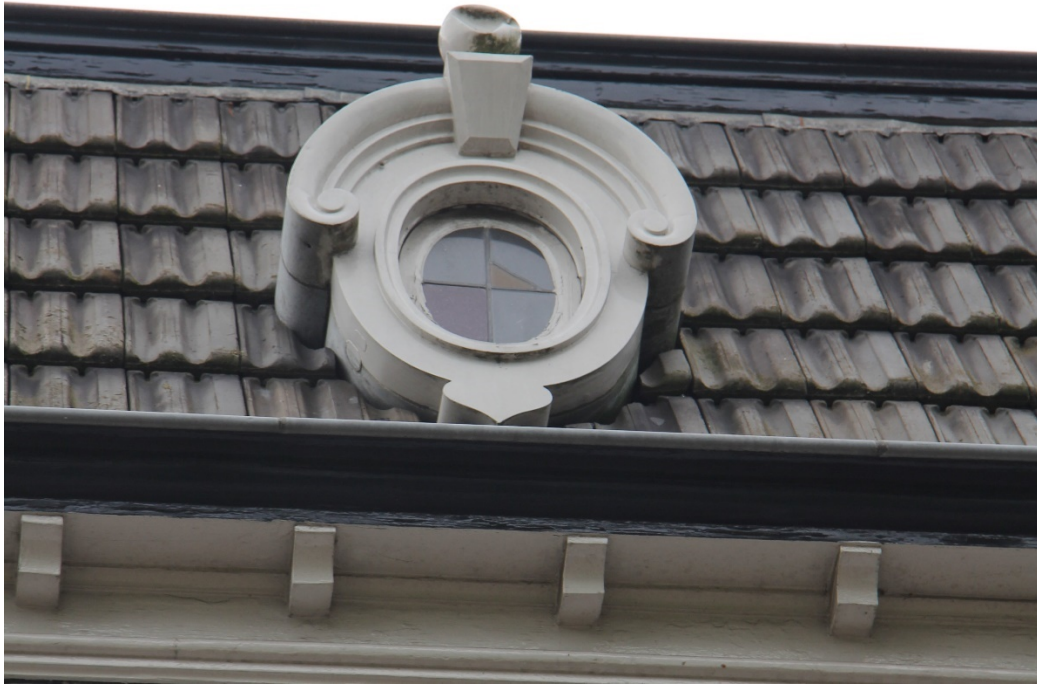
Afb. 37. Details zijn belangrijk. Hier de ronde dakkapel ook wel oel de boeuf genoemd van het gemeentelijke monument Aan de Vijftien 8 te Nederweert.
