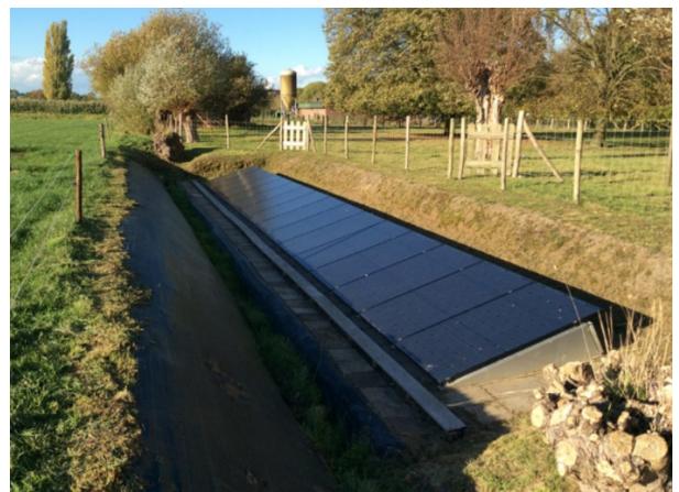
Afb. 31 en 32. Voorbeelden van oplossingen van zonnepanelen op een niet monumentaal bijgebouw en verdiept aangelegd in een waardevol en kwetsbaar groengebied (bron RCE)
