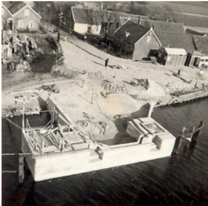
Foto van de bouw van de Vrouwenakkerse brug, 1939/40 Bron Foto: T.Harting, geb.Enthoven.
