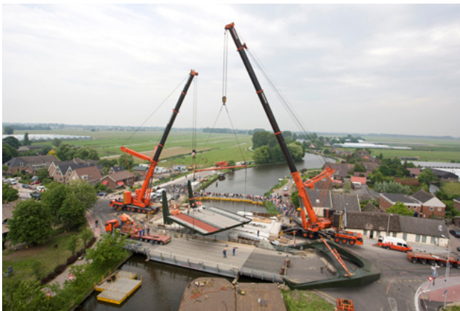
Bouw nieuwe brug Vrouwenakker (2008)
