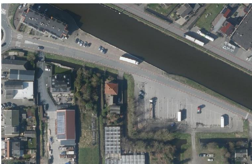
Figuur 20: Wegbeeld Oostkanaalweg tussen bebouwde komgrens en rotonde Kerkweg
