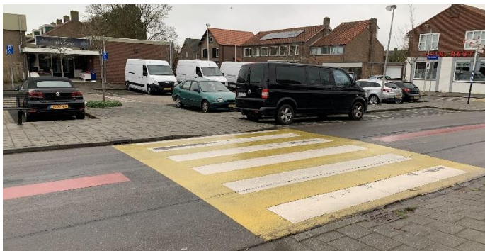
Figuur 23: Gele ondergrond bij voetgangersoversteekplaats op Kerkweg
