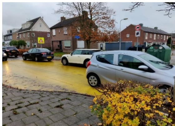
Figuur 6: Wachtrijvorming op het kruispuntvlak en rechts een zichtbelemmerende afvalcontainer.
