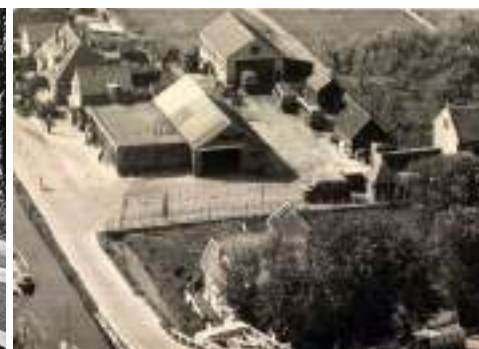
figuur 17: Voormalige busremise op locatie van sporthal 'De Vlinder'.
